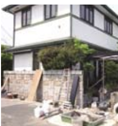
外構工事施工中
