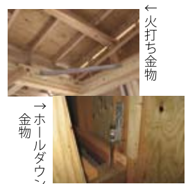
●耐震補強工事の一例
