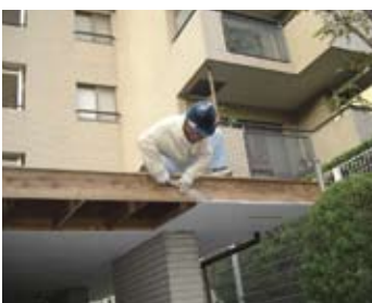
破風補修工事
