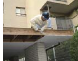
破風補修工事
