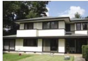
外壁塗り替え後
