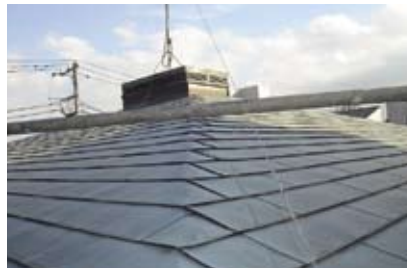
銅板屋根改修中
