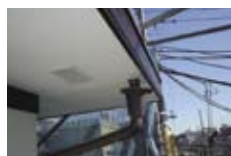
屋根・外部検査（樋・軒）
