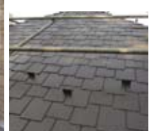
屋根塗り替え工事中
