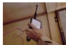
壁内雨漏れ検査
