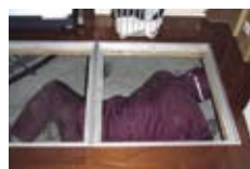
床下検査（漏水・腐朽・白蟻）
