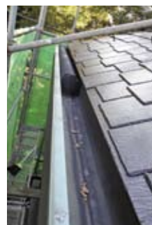
雨樋点検取り換え
