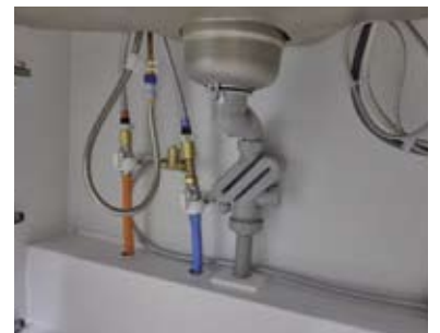
室内排水管点検
