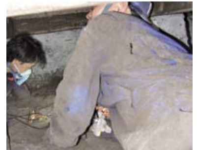
床下の水漏れ・白蟻検査
