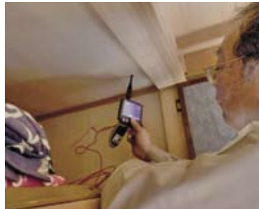
ファイバースコープによる目視検査
