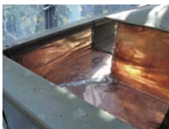
雨樋（銅板）補修
