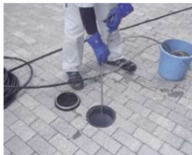
外部排水管点検・クリーニング
