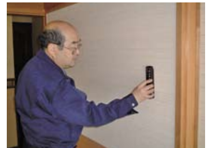
室内耐力壁検査
