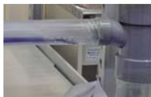
ローリング配管洗浄
