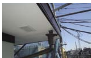
雨樋点検補修工事
