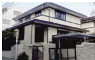
外壁塗り替え工事
