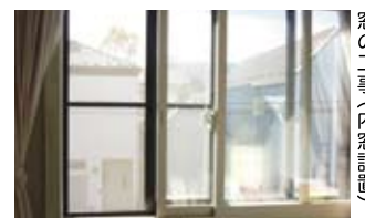
窓の工事（内窓設置）
