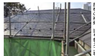
屋根の補修・塗り替え工事
