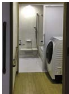
段差解消・手すり設置
