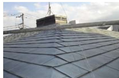
銅板屋根補修
