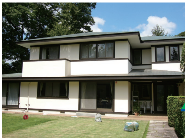
くらしの共生舎の外壁・屋根塗り替え
