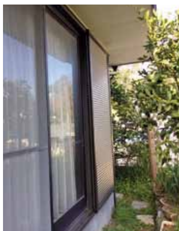
雨戸の取り付け
