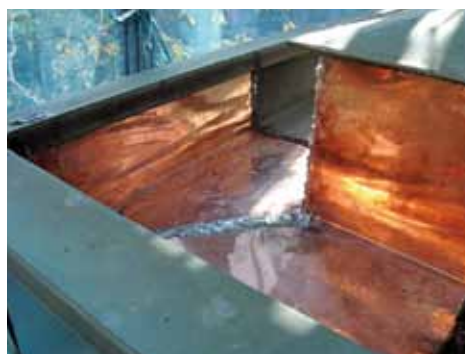
雨樋（銅板）補修
