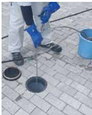
外部排水管点検・クリーニング
