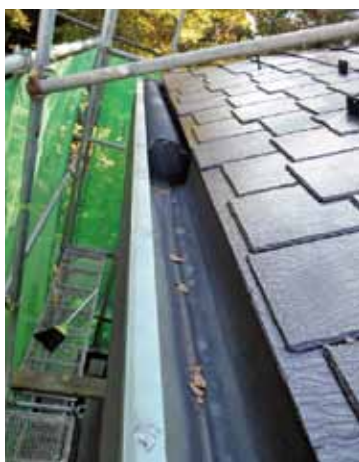
雨樋点検取り換え
