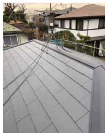
屋根棟押えの補修
