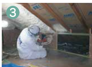
天井 断熱工事
