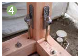
耐震金物の設置
